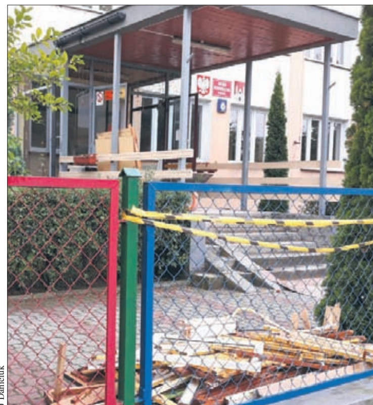
Rozpoczęła się przebudowa przedszkola nr 6 przy ul. Łączniczek
